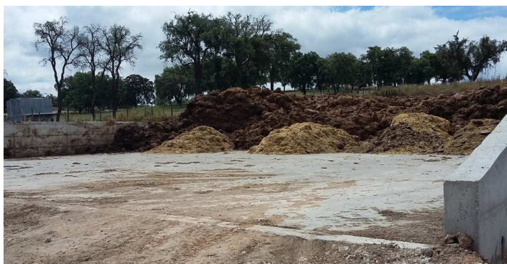
Figura 9 - Placa de estrume (ARH)
