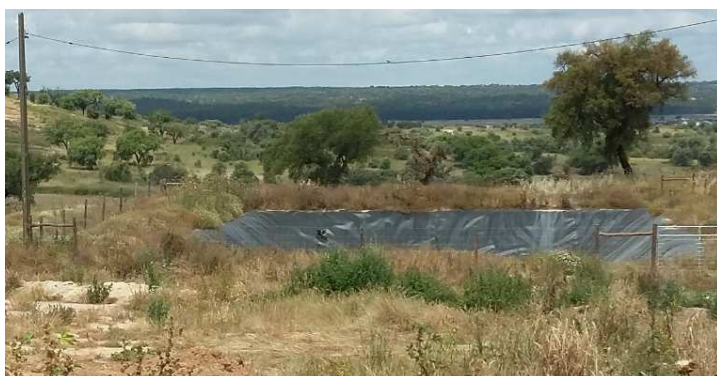
Figura 11 - Lagoa de retenção de efluentes (ARH)
