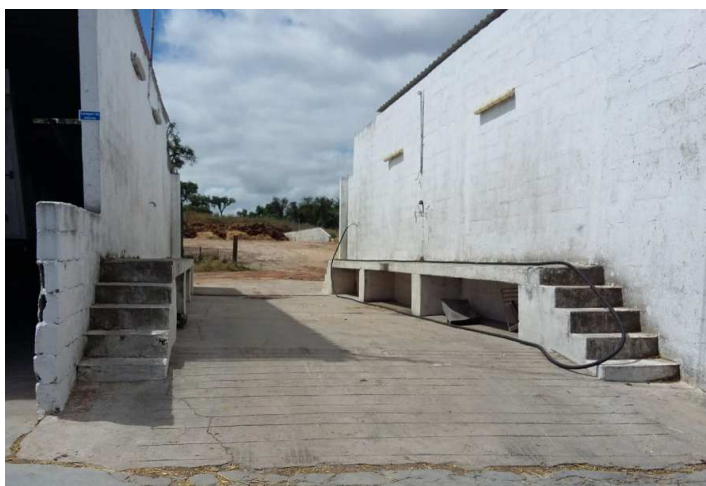
Figura 10 - Área de lavagem de veículos de transporte de animais (ARH)
